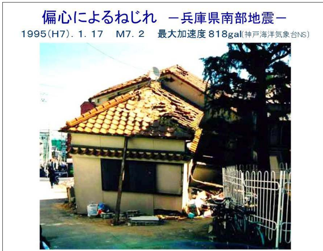
図 3-9 偏心によるねじれー兵庫県南部地震ー
