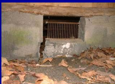
図 3-4 三陸南地震 被害例
