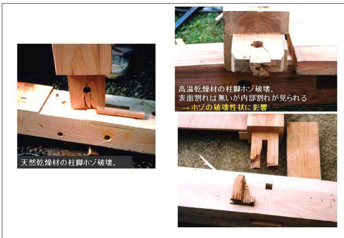
図 2-6 乾燥の違いによるホゾの破壊性状
