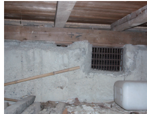
布基礎の劣化
