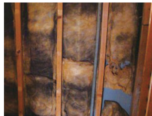
結露によるグラスウールの劣化
