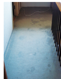
カーペット床の汚れ・劣化
