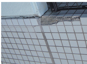
タイル部の割れ
