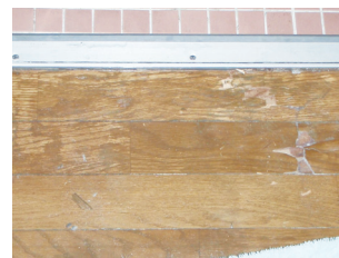
浴室床の劣化
