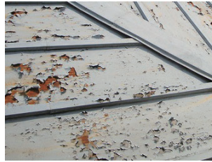
屋根塗装の劣化
