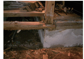
白蟻による損傷
