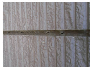
コーキングの劣化
