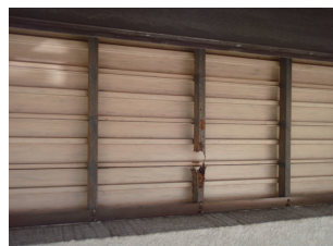
外付けバルコニーの劣化
