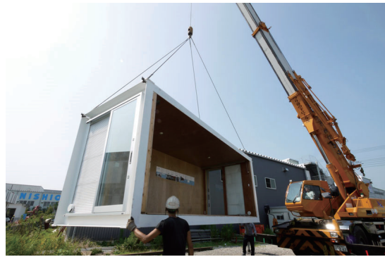
クレーン車で持ち上げられ設置
