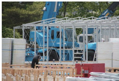
部材はコンテナで運ばれてくる
