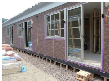
（出典：東日本大震災における応急仮設住宅の建設事例 国土交通省）
