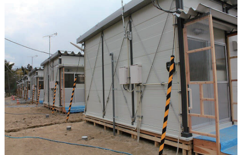
岩手県陸前高田市の中学校のグラウンドに設置した応急仮設住宅（写真：日経アーキテクチャ）
