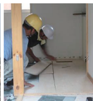
床仕上げ材の取り外し
